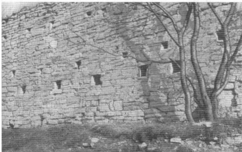
Рис. 146. Гнезда балок раската в стене Псковского захаб.
