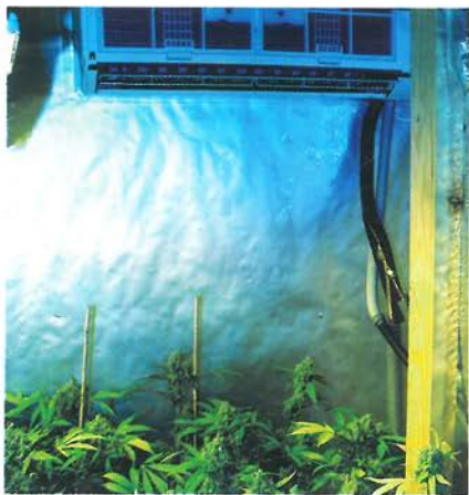
Этот кондиционер понижает температуру и влажность оранжереи. Горячий радиатор выводится наружу на высоту 3 м от земли.
