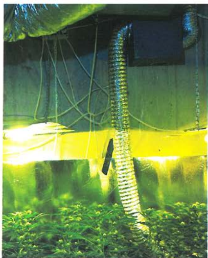
Бустер-вентилятор в серой коробке заставляет всасываемый воздух проходить по трубе к низу сада.
