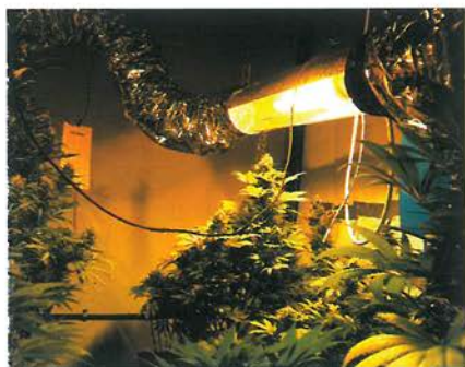
Осветительная система, охлаждаемая воздухом, требует установки вентиляторов, которые бы направляли и выводили выделяемое лампой тепло из гофры.
