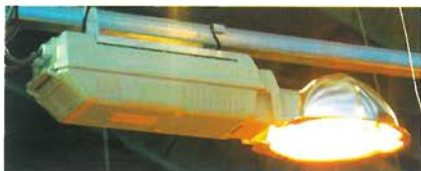
Балласт в этой тепловой системе крепится к лампе и рефлектору.
