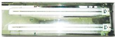
Каждая из 50-сантиметровых ламп потребляет 44 ватта электроэнергии.
