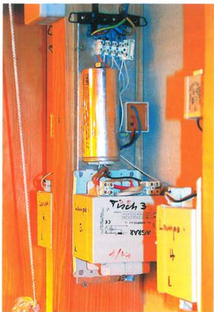
Прикрепите балласты на стену, чтобы они не мешались.
