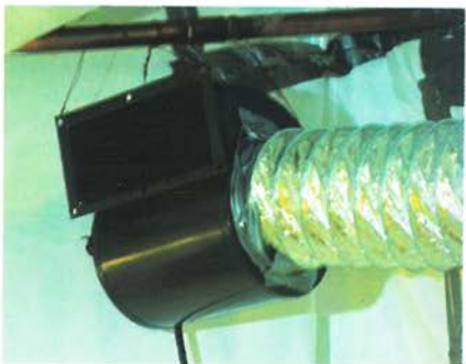
Этот вентилятор находится у конца трубы, всасывающей воздух. Главный вентилятор — на другом конце.
