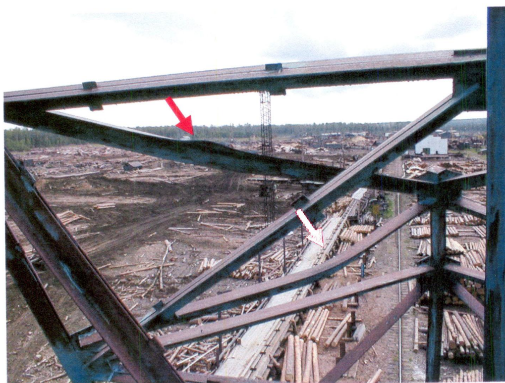
Рис. 1.13. Деформации раскосов пролетного строения
