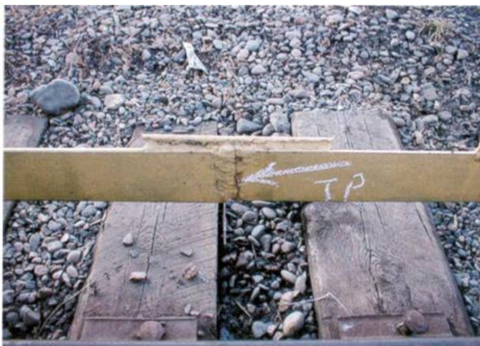
Рис. 1.11. Трещины и деформации в стяжках стоек опор (ККС-10)
