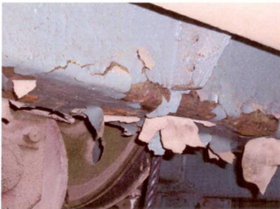
Рис. 1.9. Неудовлетворительное состояние окраски и начальная коррозия металлоконструкций в местах отслоения и шелушения краски
