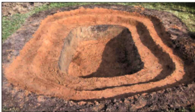
Котлован готов к укладке плёнки.
