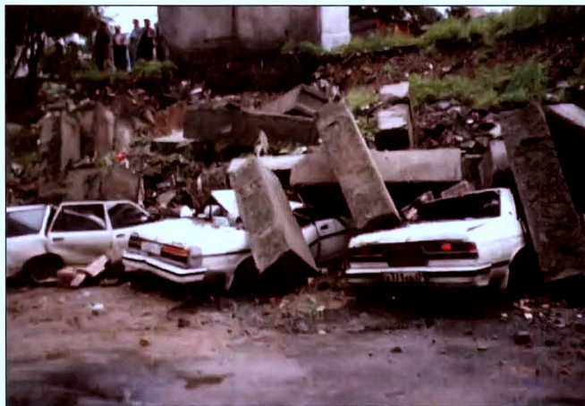
Разрушение подпорных стенок всегда приводит к серьёзным последствиям. Так, обломки обрушившейся стенки в одном из районов Владивостока раздавили несколько автомобилей. Лишь по счастливой случайности не пострадали люди.
