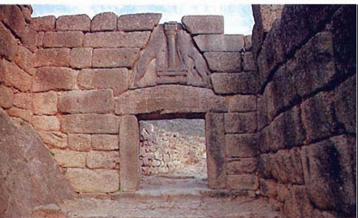
Знаменитые «львиные ворота» в Микенах. Прямоугольные блоки ворот и стены рядом с ними контрастируют с грубо обработанными многоугольными блоками, из которых сложены другие части стены.
