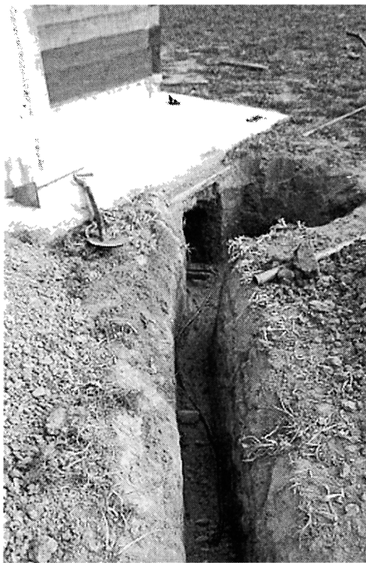
Рис. 2.108. Траншея для прокладки кабеля
