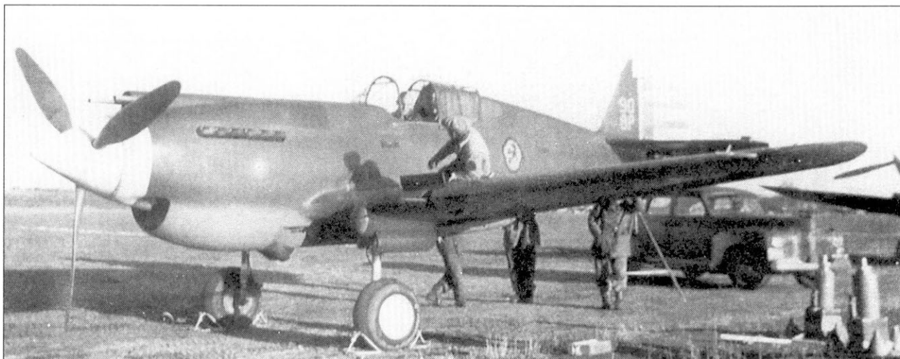
P-40B из 36th PS, 8th PG. Пример ранней окраски. На руле поворота присутствуют цветные полосы, которые убрали с боевых самолетов во второй половине 1940 года.
