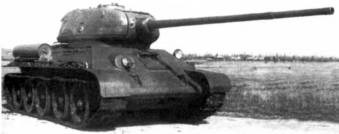
Танк Т-34-85 с установкой 85-мм пушки ЗИС-1 в серийной башне. Весна 1945 года (ЦАМО).
