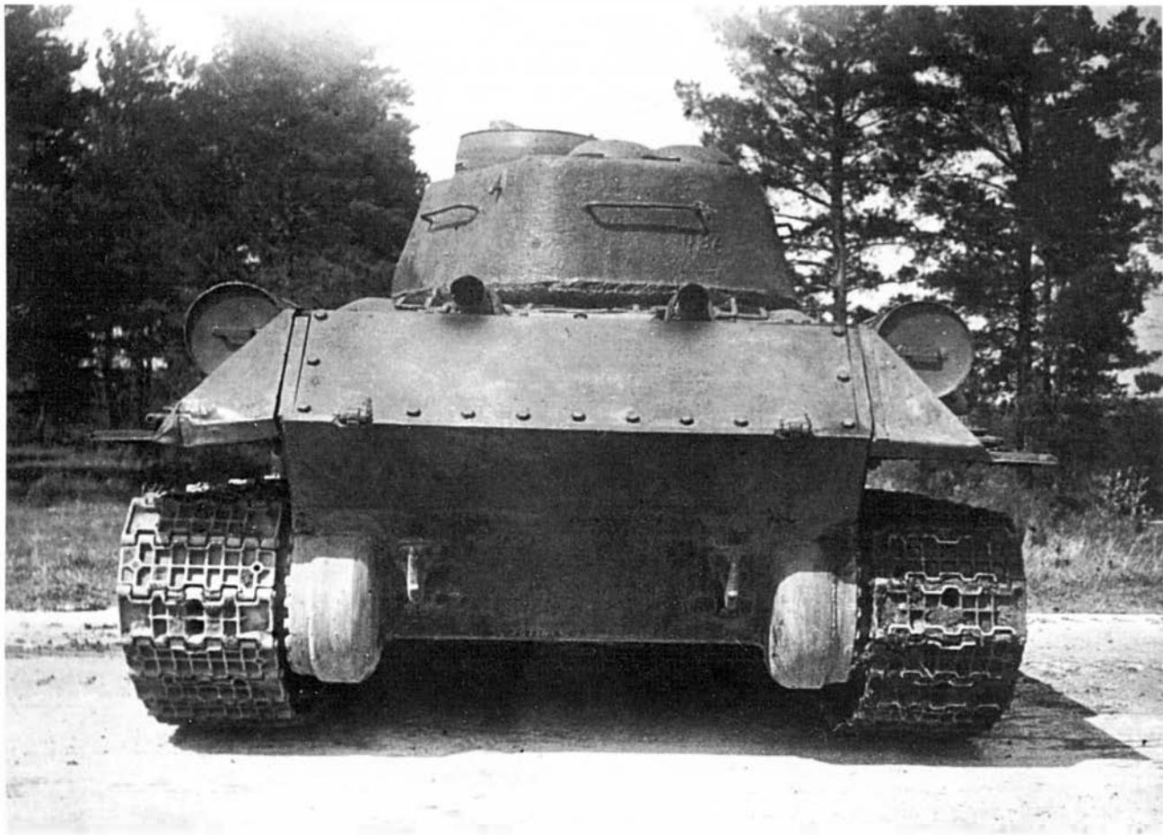
Танк Т-34-85М второго варианта с усиленным бронированием лобовой части корпуса и перенесенными в корму топливными баками, вид сзади. Май – июнь 1944 года (ЦАМО).
