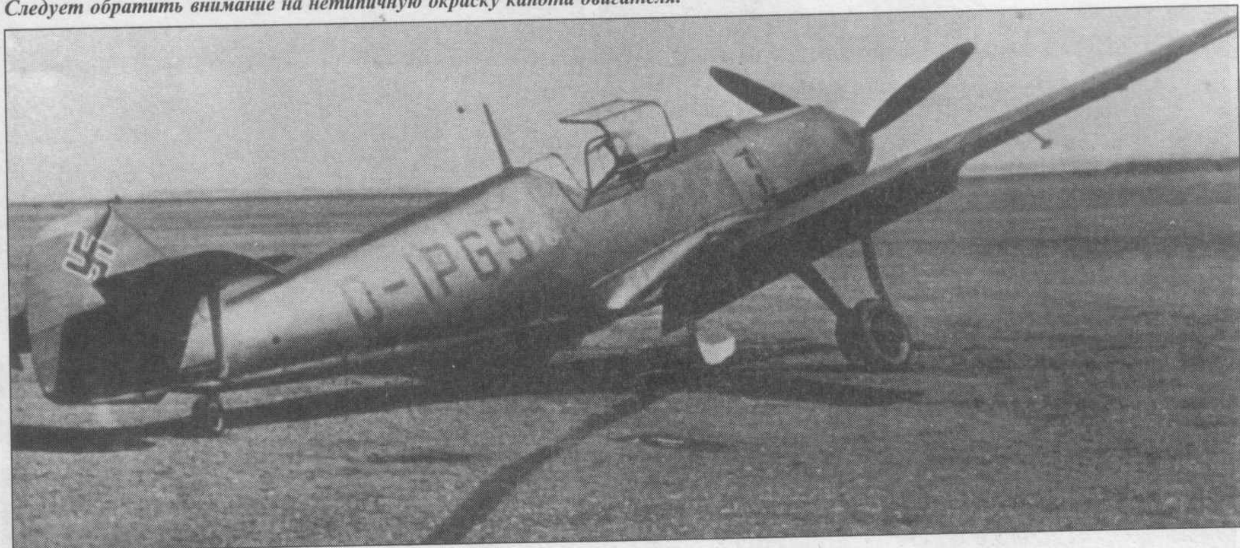
Один из первых Me 109E (D-IPGS) с подломившейся левой стойкой шасси, 1939 год.
