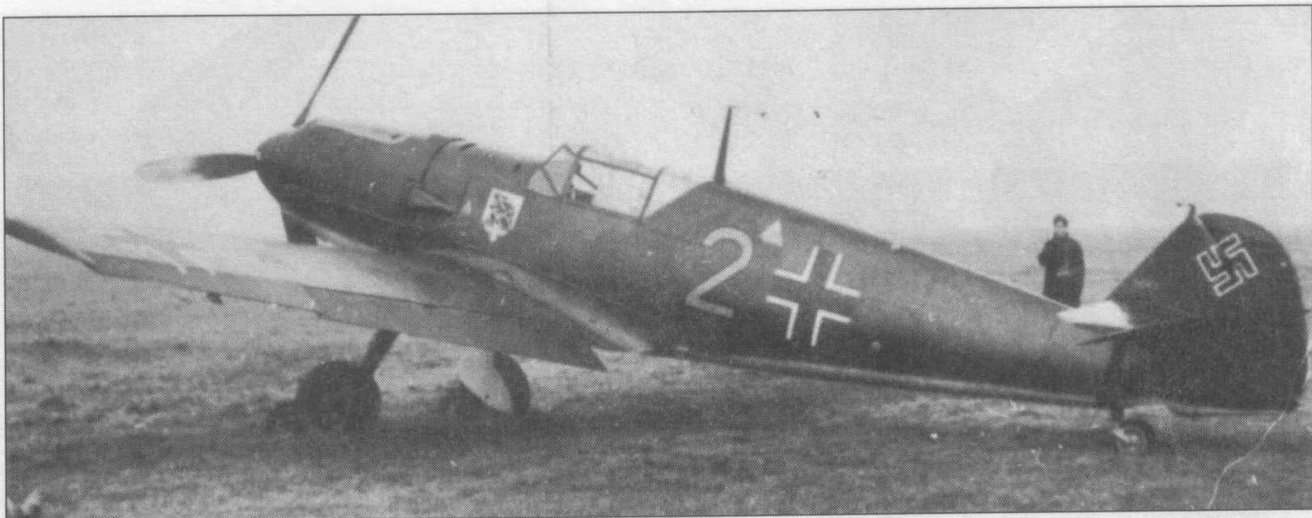
Me 109E-1 «желтая 2» из JG 21 (позднее JG 54). Машина в стандартном камуфляже дневного истребителя (Tag Jagd). Опасаясь ударов по аэродромам, гитлеровцы использовали темный верхний камуфляж 71/70, в то время как днище покрывали светло-голубой краской RLM 65. Свастика на хвостовом оперении центрирована относительно верхней петли руля направления.
