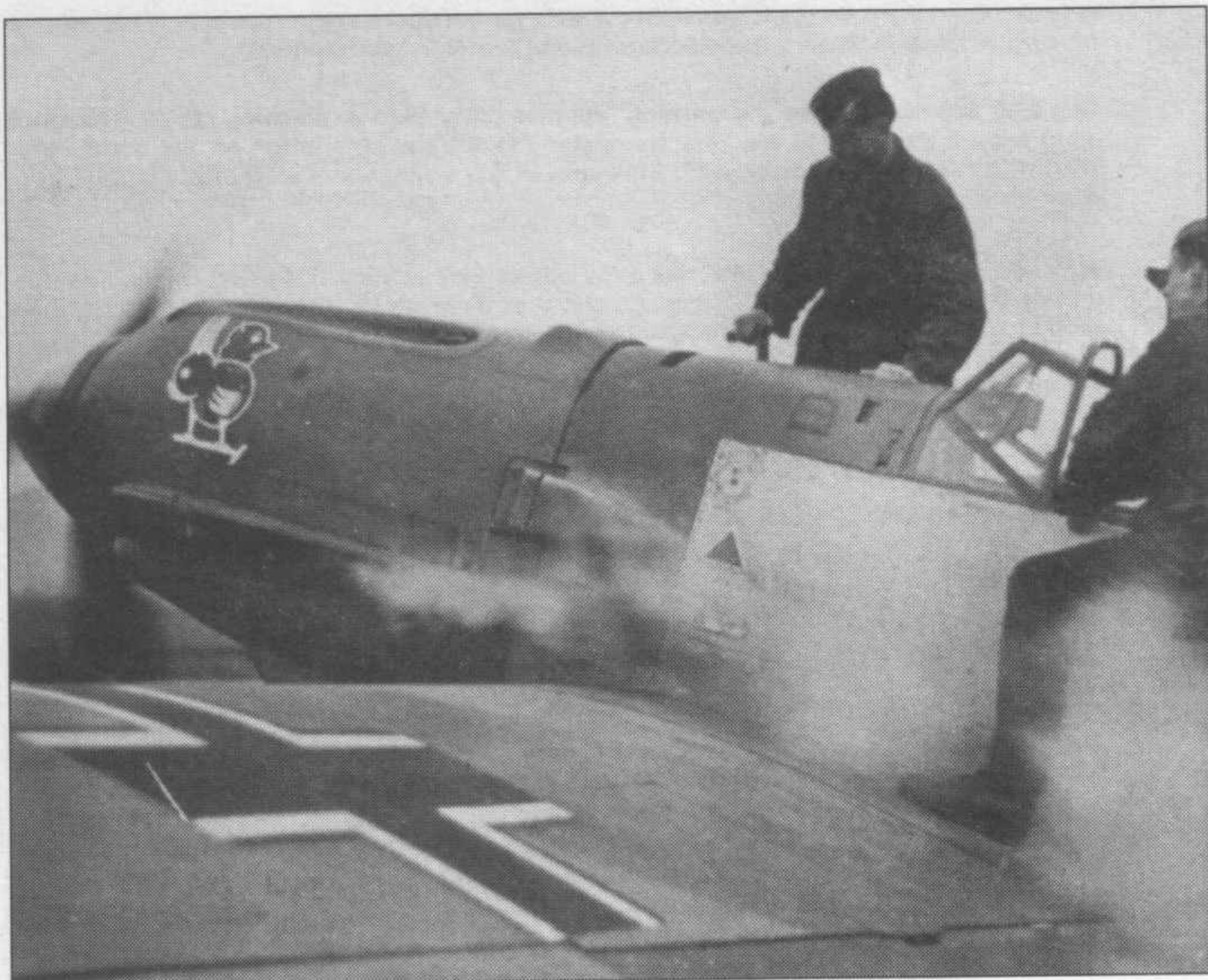
«Белая 3» из III./JG 54 - Me 109E-4 с бронированной кабиной, лето 1941 года, Восточный фронт. Обычным элементом быстрой идентификации на Восточном фронте выступали желтая полоса на фюзеляже или желтый руль направления. Позднее появились желтые законцовки крыльев. Желтый капот остался от прежних кампаний.
