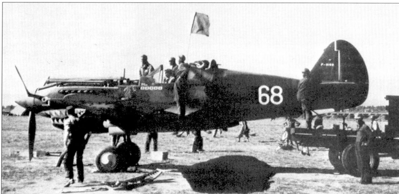
P-40B из 3-й эскадрильи «Hell's Angels» AVG, подготовленный для пристрелки пулеметов. Видны китайские опознавательные знаки на нижней поверхности крыльев. Английский камуфляж Dark Earth/Dark Green/Sky. Номер P-8109 указывает на то, что самолет принадлежит первой сотне машин, предназначенных для англичан.
