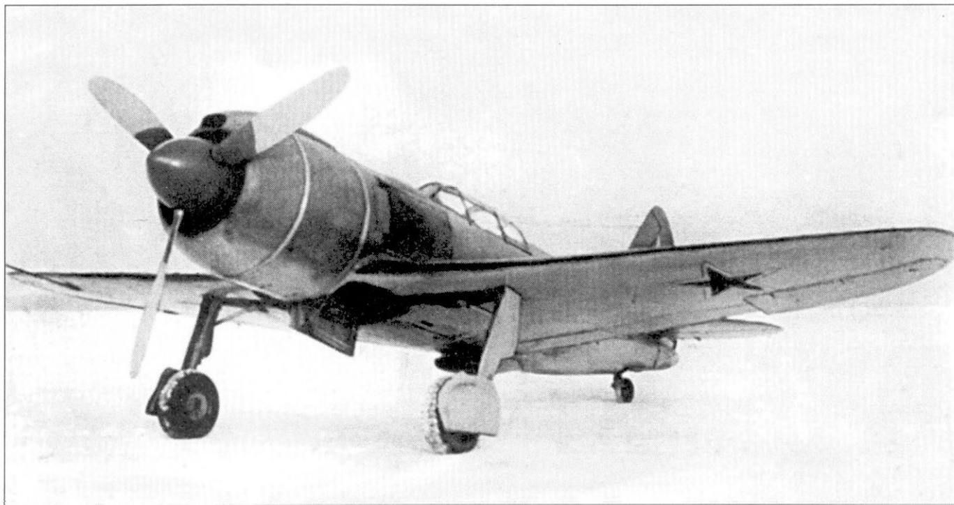
Вид 3/4 спереди на экспериментальный Ла-7Р. Обратите внимание - воздухозаборник нагнетателя перенесен на капот двигателя, как на Ла-5, маслорадиатор остался на обычном для Ла-7 месте в нижней средней части фюзеляжа.
