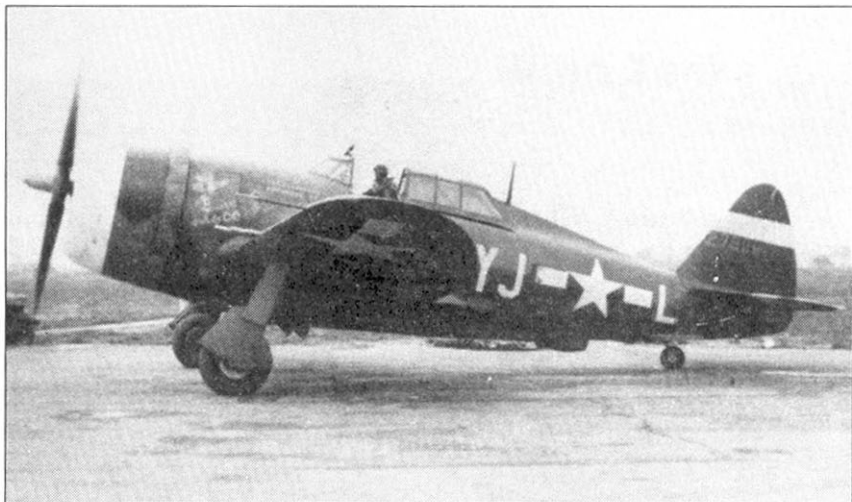
Истребитель P-47D ранней производственной серии сфотографирован на аэродроме Микс-Филд в Исландии. Здесь «Тандерболты» заправлялись горючим при перелете через Северную Атлантику из США в Великобританию. Истребитель P-47D-1 можно отличить от P-47C по дополнительным отклоняемым поверхностям «юбки» капота двигателя. Обратите внимание на дополнительные подкрыльевые топливные баки фирмы Локхид.
