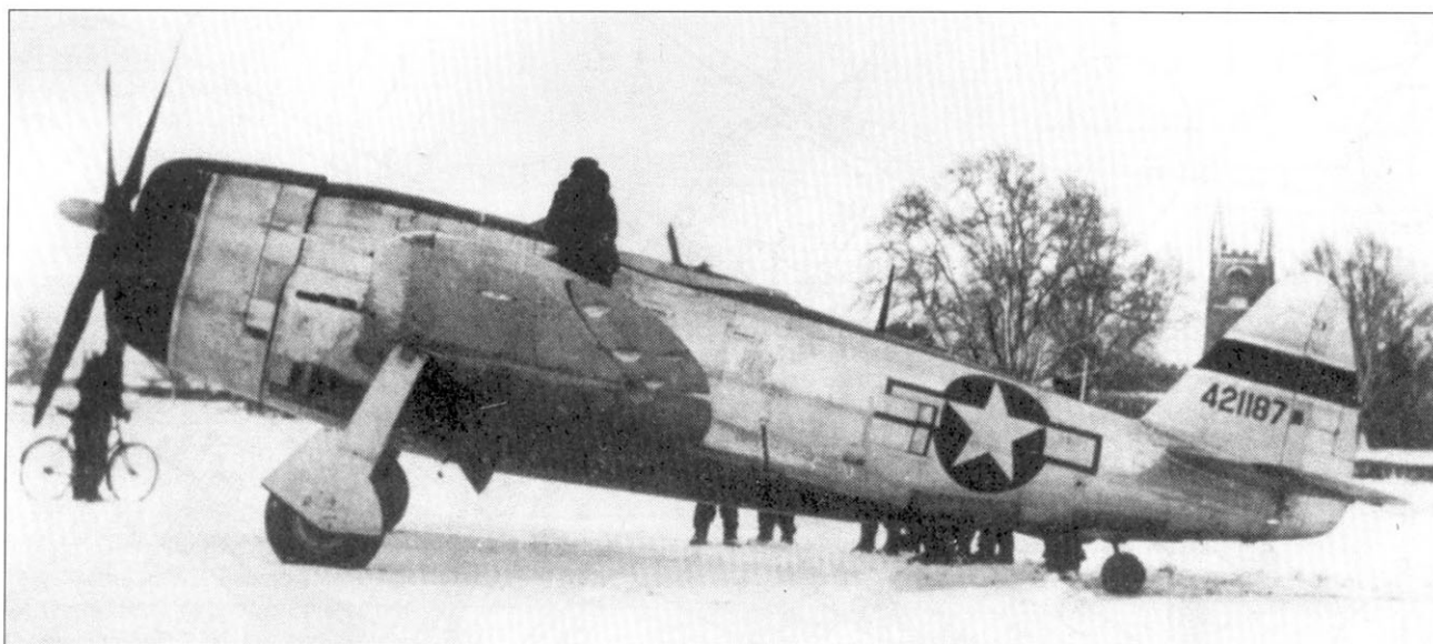
Первые истребители P-47M начали прибывать на Британские острова в конце 1944 г. На снимке - P-47M-1-RE. Снимок сделан сразу после доставки истребителя в Великобританию - отсутствует символика подразделения и не установлены подкрыльевые пилоны.
