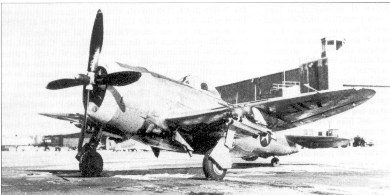
«Тандерболты» имели возможность нести только по паре неуправляемых ракет HVAR под каждой плоскостью крыла. Снимок сделан в Фэрмидэйле, истребитель оснащен воздушным винтом Кертисс Электрик.
