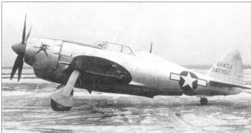
Самым скоростным «Тандерболтом» стал XP-47J. Облегченный самолет с двигателем R-2800-57 мощностью 2800 л.с. 5 августа 1944 г. развил скорость 505 миль/ч.
