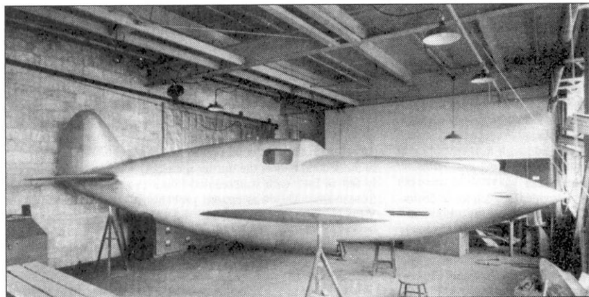
Предназначенный для продувок в аэродинамических трубах макет истребителя AP-10/XP-47.
