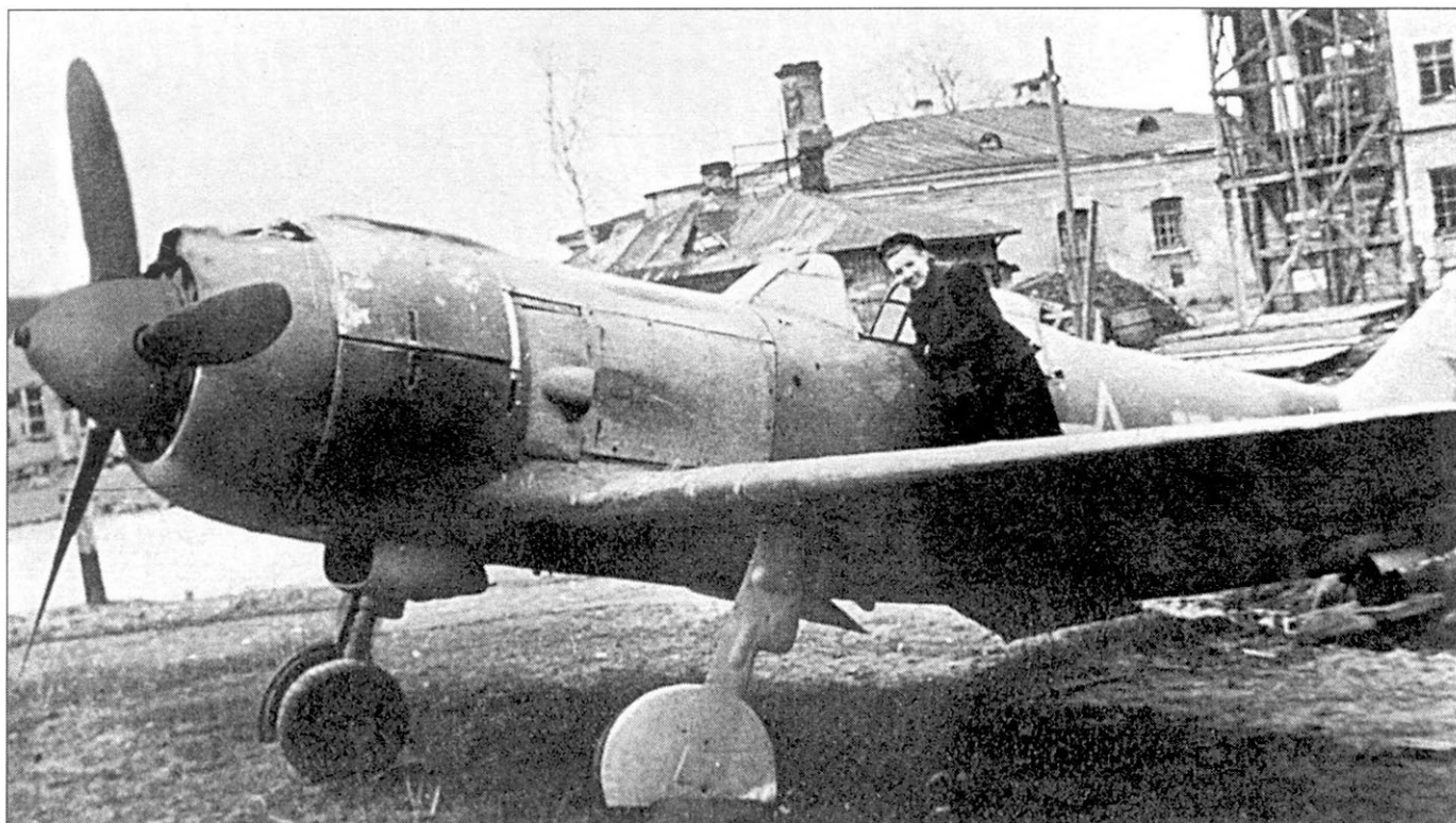
На снимке - Ла-5Ф ранней серии выпуска. Мачта радиоантенны характерна для самолетов именно первых выпусков, обратите внимание - опознавательные знаки (звезды с белой каймой) - образца 1944 г.
