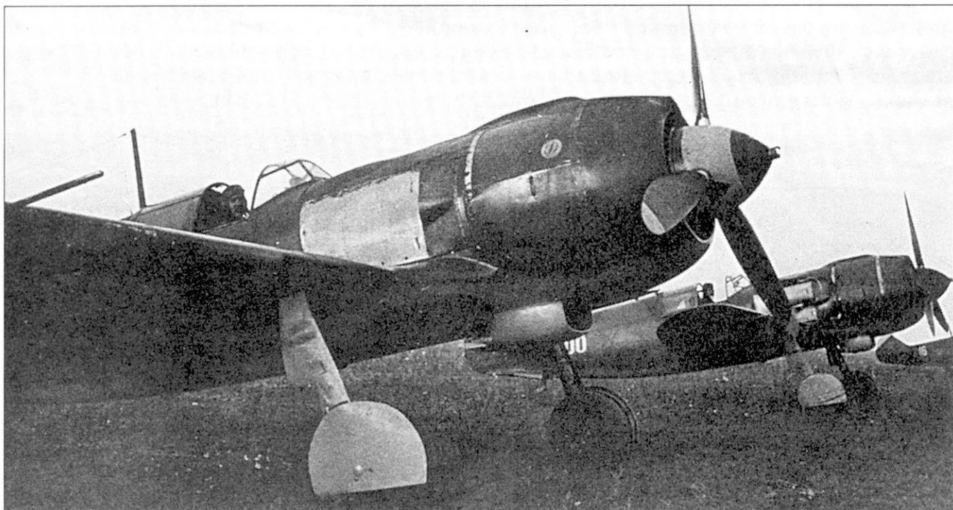
Полевой аэродром в районе Белгорода, лето 1943 г. На переднем плане Ла-5 с необычно окрашенным черно-желтым коком винта, на втором самолете кок полностью желтый. Обратите внимание на логотип «Ф», нанесенный на капот двигателя.
