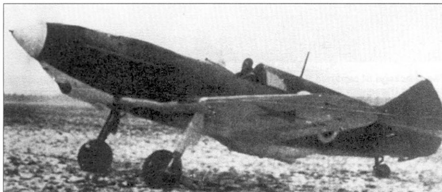
Летные характеристики истребителей ЛаГГ-3, и без того не очень высокие, еще больше ухудшались из-за того, что в полках демонтировали сдвижные сегменты фонарей кабины и нижние створки щитков основных опор шасси.
