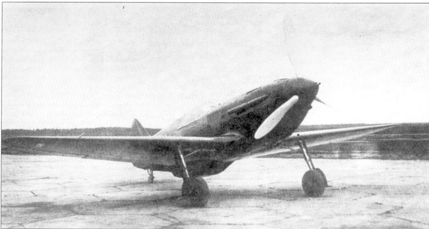
Второй прототип И-301 на летных испытаниях, аэродром Летно-испытательного института, Жуковский, ноябрь 1940 г. В отличие от серийных ЛаГГ-3, на И-301 не имелось посадочной фары под левой плоскостью крыла.
