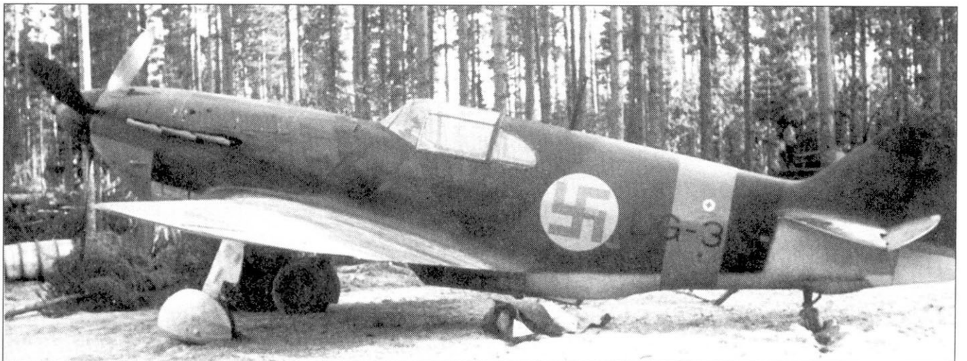
Летом 1944 г. на истребитель ЛаГГ-3 «LG-3» была установлена короткая мачта для крепления радиоантенны, похожая на мачты, которыми оснащались истребители ЛаГГ-3 первых производственных серий. Обратите внимание - в передней части фюзеляжа желтая идентификационная полоса сверху закрашена оливково-зеленой краской.
