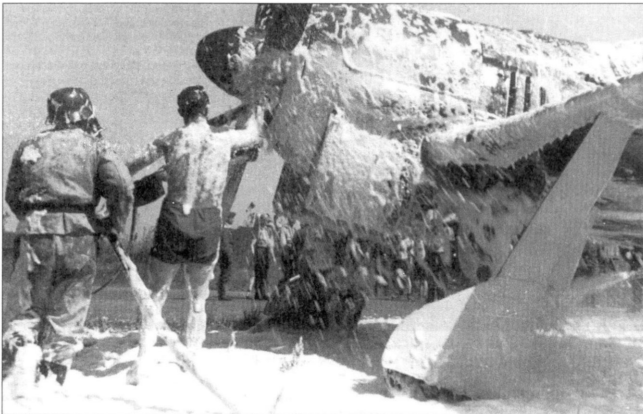
Обычная сцена на аэродроме в период начала освоения истребителей Fw-190. Пожары были обычным явлением, происходившим из-за перегрева моторов BMW-801.
